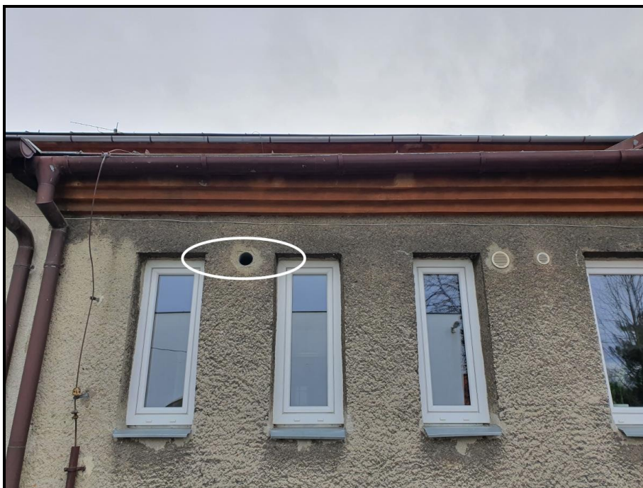
Obr. 3: Nezabezpečený ventilační otvor (elipsa) na severní straně domu – potenciální stanoviště synantropních živočichů
